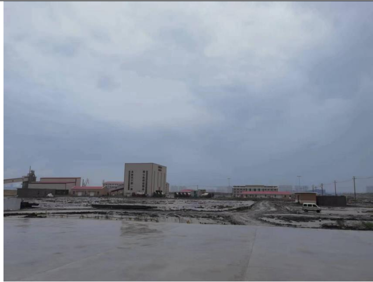
图 2.4-1 现有项目建设现场图
